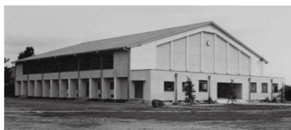
完成した体育館(40周年)
